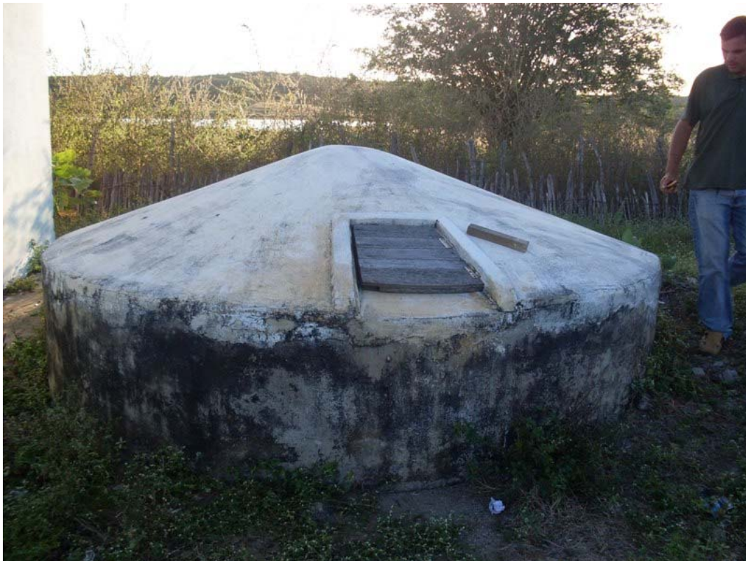
Figure 4.71: Rainwater Cisterns (P1MC) in Sítio Fortaleza.
