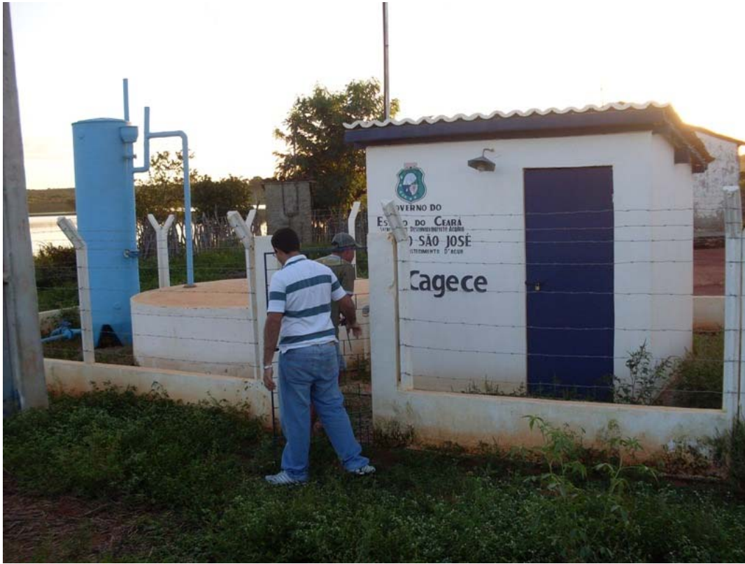
Figure 4.54: CAGECE's ETA in Riacho do Meio - São José Project.
