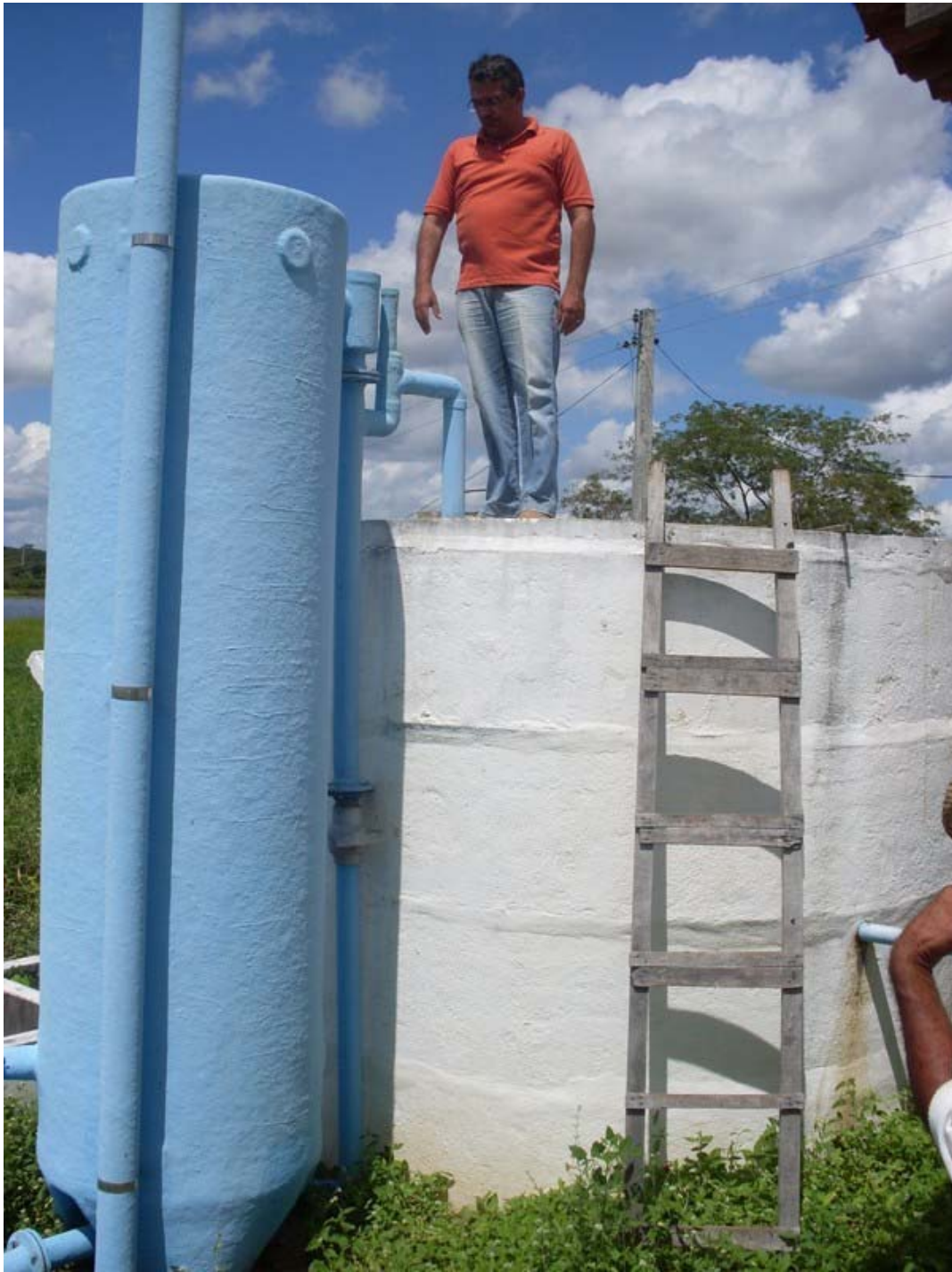
Figure 4.63: ETA Filters in Pedra Fina.
