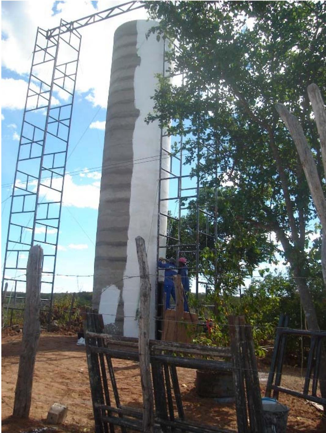
Figura 5.21: Reservatório Elevado de Ingá em fase de pintura.
