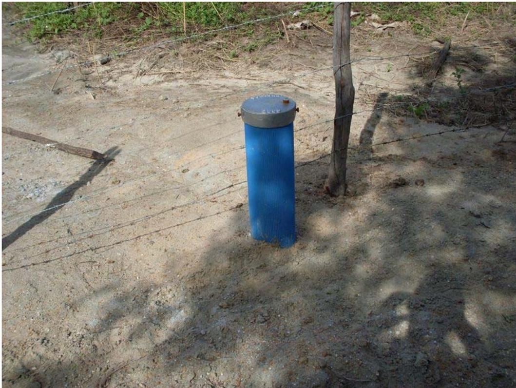
Figura 5.7: Poço Profundo em Bom Princípio. Vazão de 3,3 m<sup>3</sup>/h.
