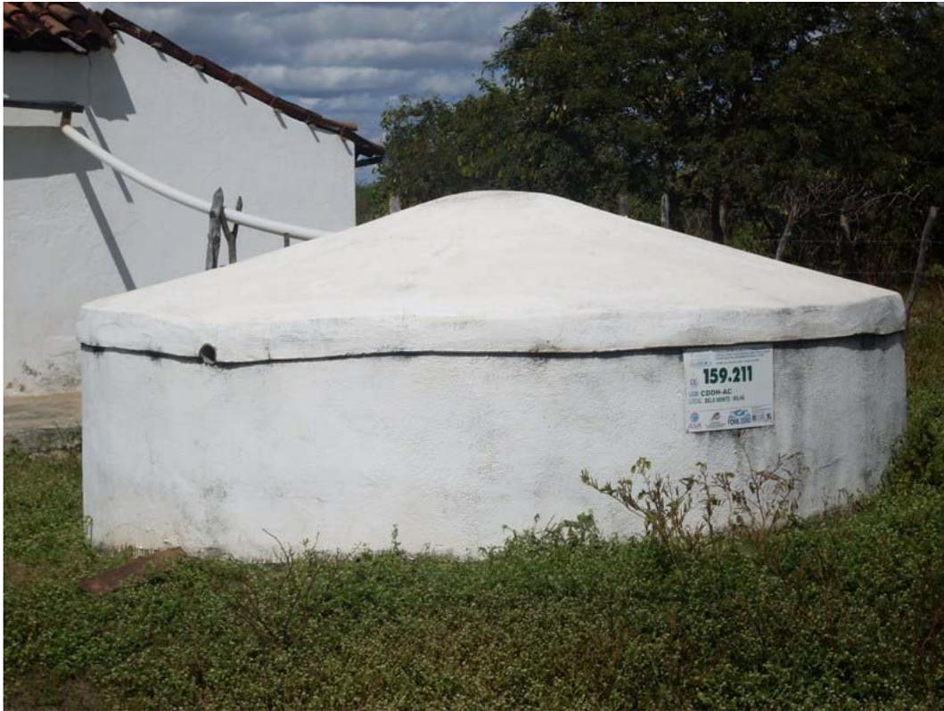
**Figura 4.118: Cisterna de placas recém-construída em Belo Monte.**
