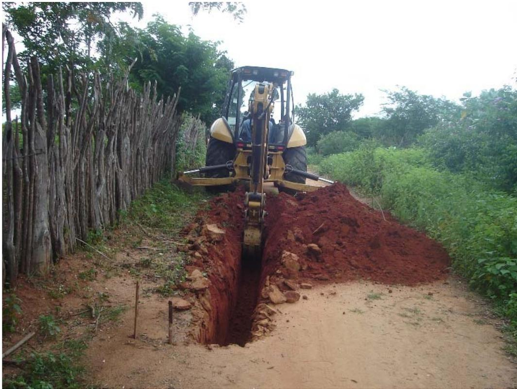
Figura 5.24: Escavadeira abrindo vala de assentamento de tubos em Ingá.
