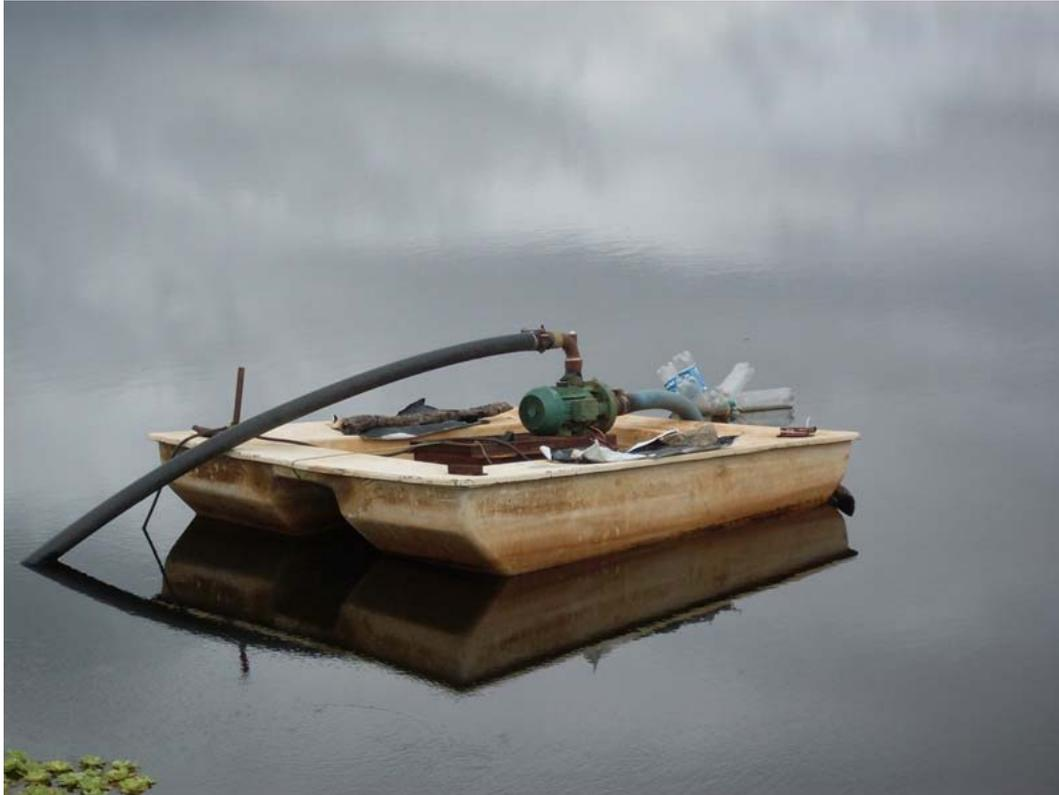
**Figura 4.2: Flutuante de captação no açude Quandu para abastecimento de Carnaubinha – Potência 5 CV.**
