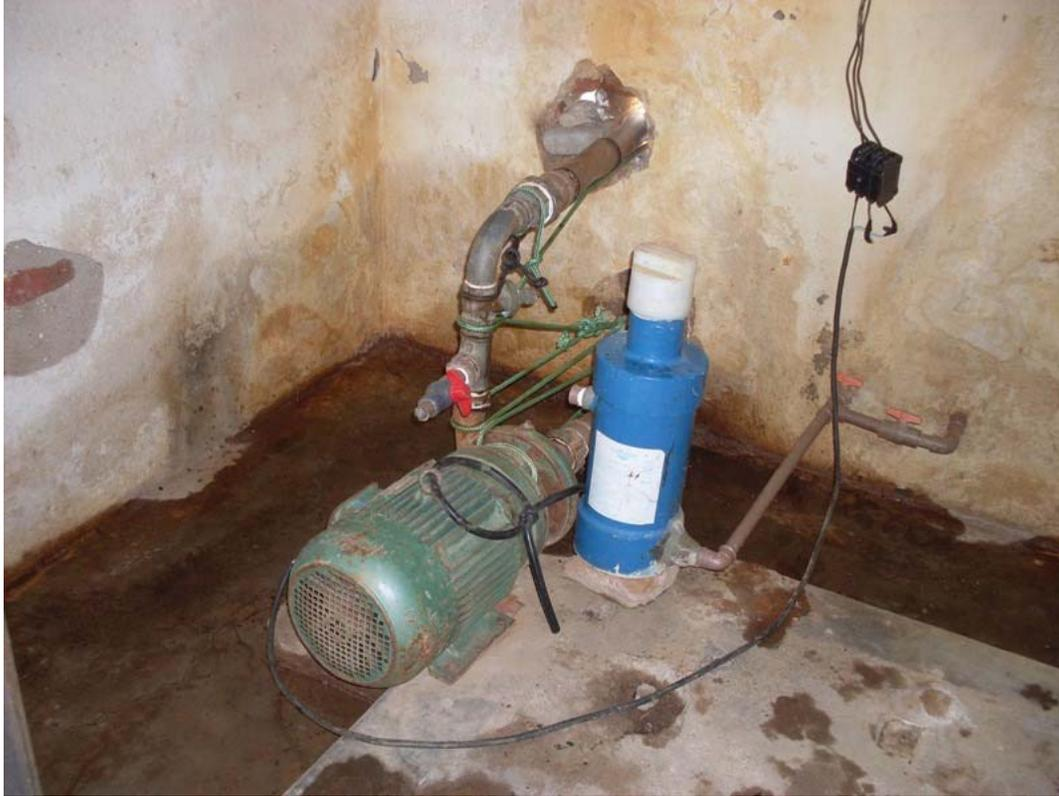
**Figura 4.4: Bombas da ETA para o reservatório elevado. Potência = 7,5 CV.**
