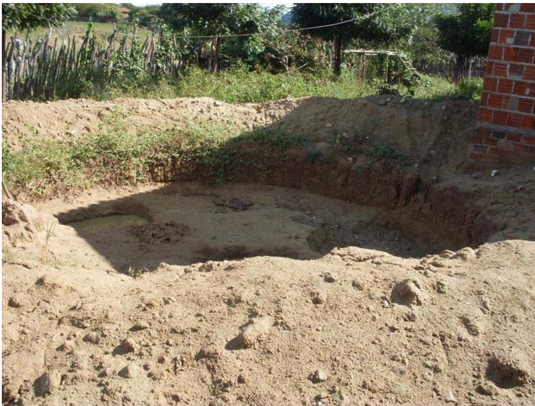
**Figura 4.131: Escavação para construção de cisterna de placas do P1MC.**
