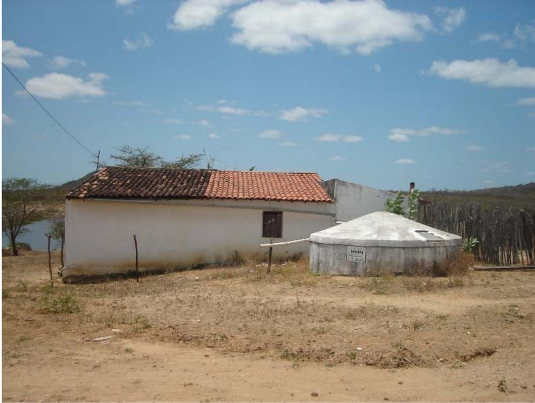
Figura 5.27: Cisterna de placas em Sítio Maré que já vazou várias vezes.
