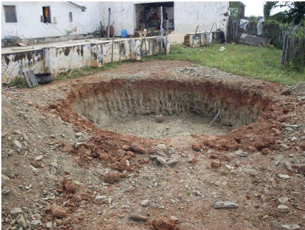
**Figura 4.85: Cisterna de placas em construção em Sabonete (P1MC).**
