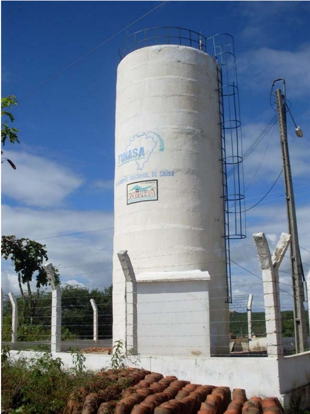
**Figura 4.12: Reservatório elevado de Açude Novo que abastece Alto Santo, Grossos, Açude Novo e Tabuleiro.**
