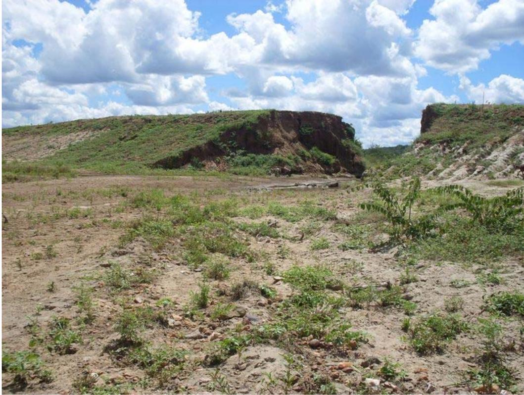
**Figura 4.121: Açude Tanques arrombado na cheia de março/2009.**
