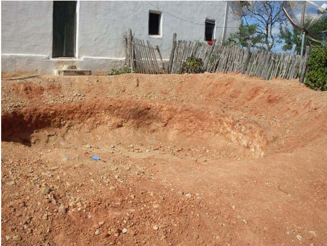
**Figura 4.108: Escavação para construção de cisterna de placas (P1MC).**
