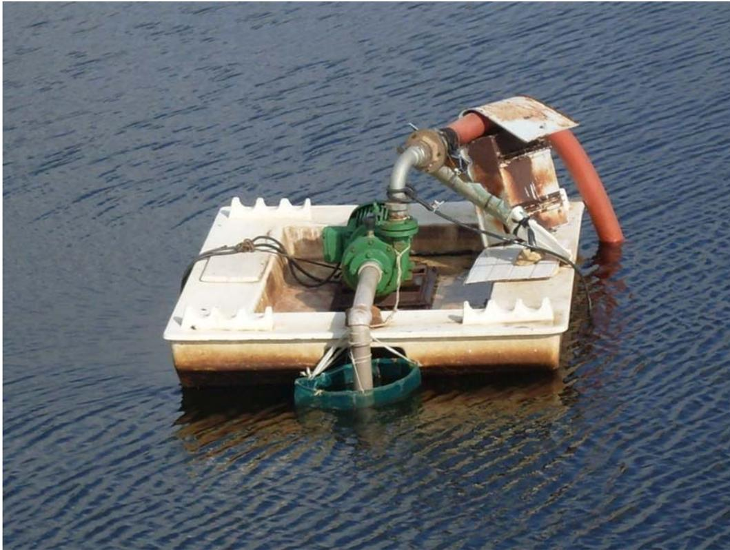
**Figura 4.134: Captação em flutuante para abastecer Milhã.**
