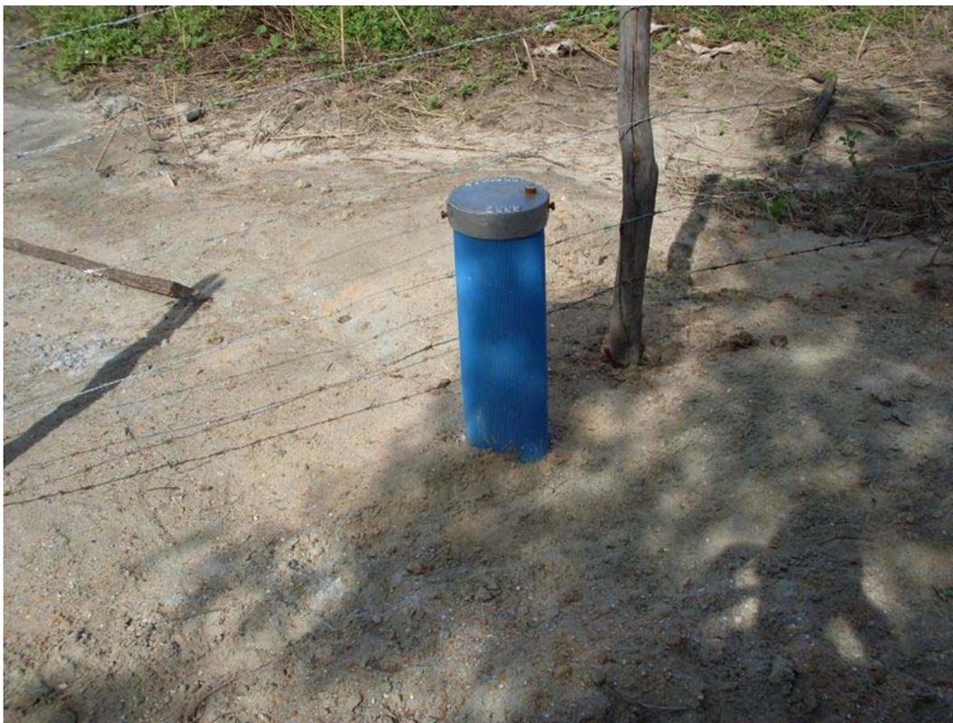
**Figura 4.90: Poço profundo na comunidade de Bom Princípio, vazão 3.300 L/h.**
