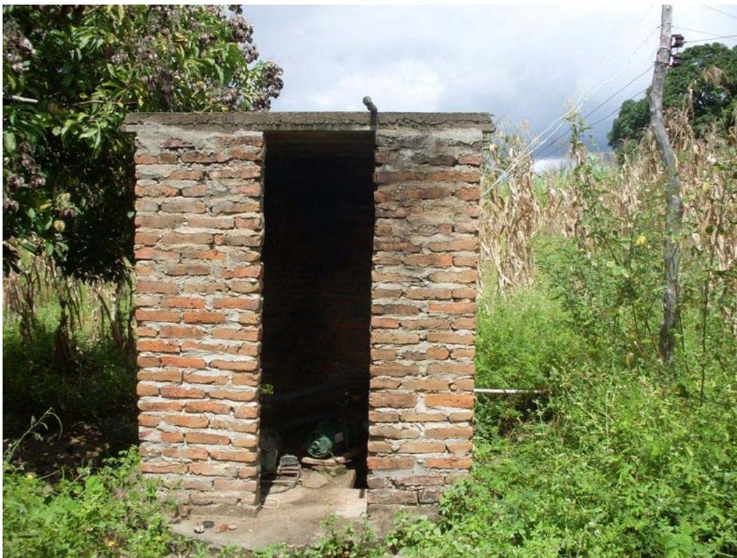
**Figura 4.25: Poço amazonas que abastece Quando com 2 bombas.**
