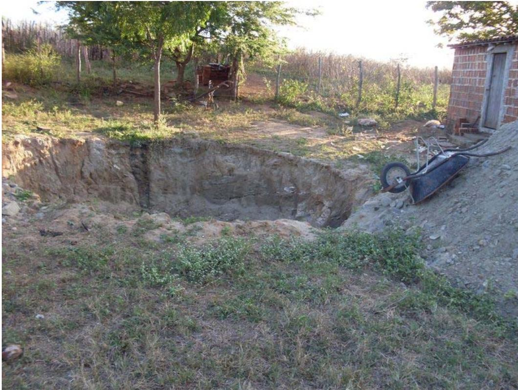
**Figura 4.102: Cisterna do P1MC em construção na comunidade Macaco.**
