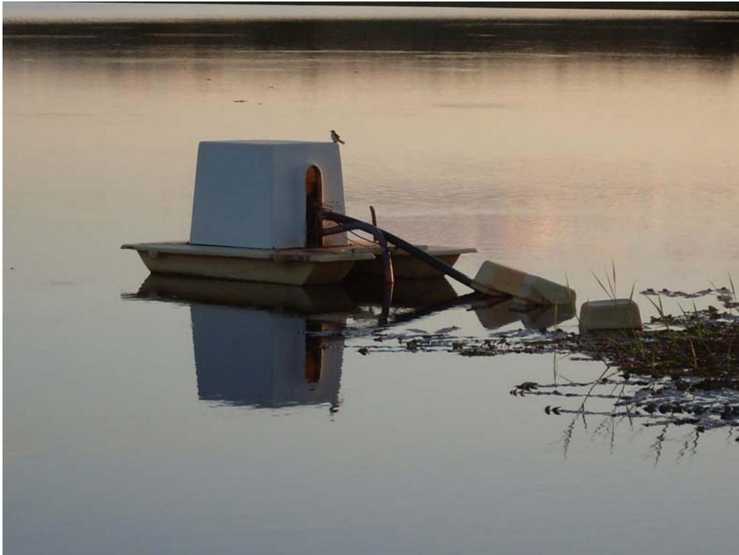
**Figura 4.53: Flutuante para captação de água no açude Riacho do Meio.**
