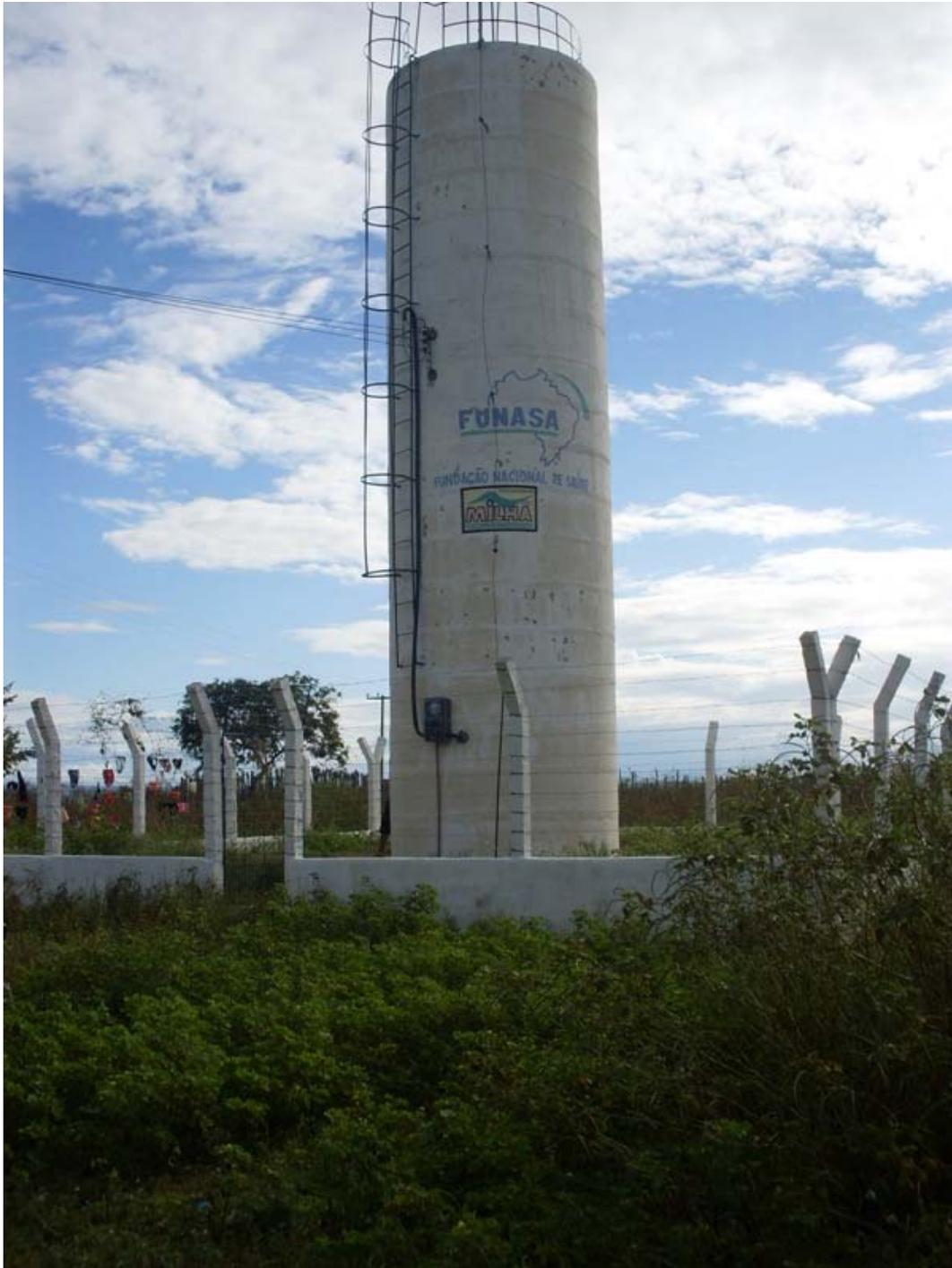
**Figura 4.13: Reservatório elevado de 21 m<sup>3</sup> de Tabuleiro.**
