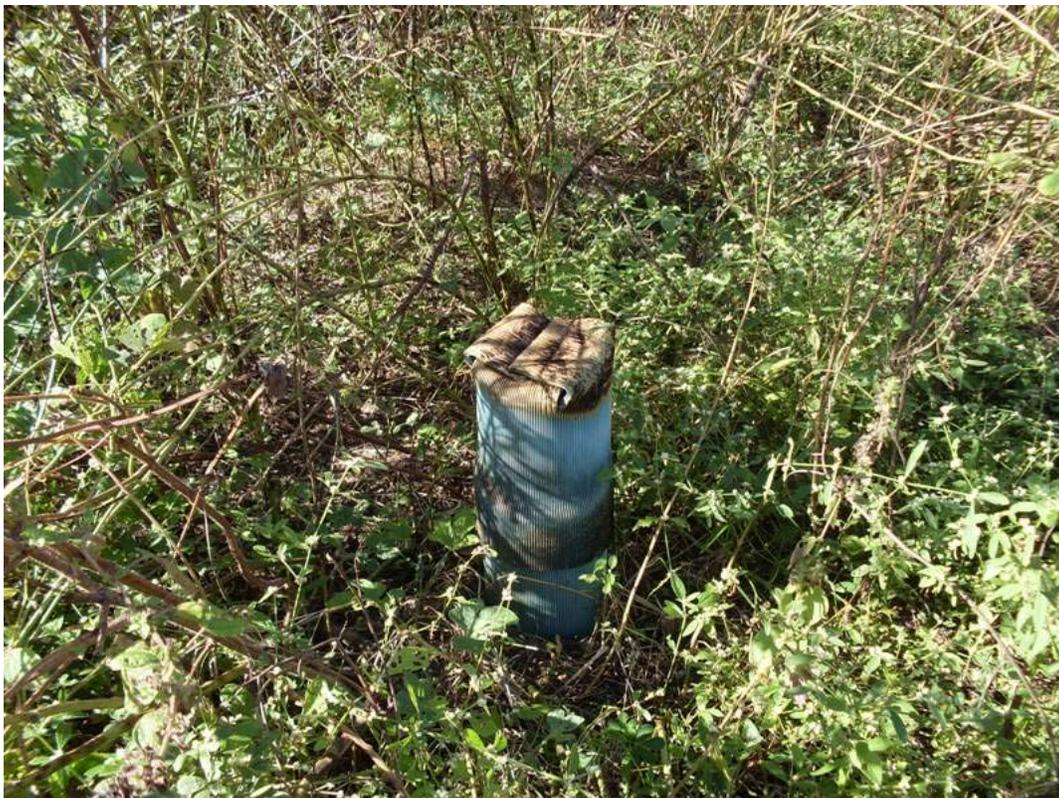
**Figura 4.33: Poço profundo em Santa Fé que poderia ser empregado para abastecimento durante as estiagens.**
