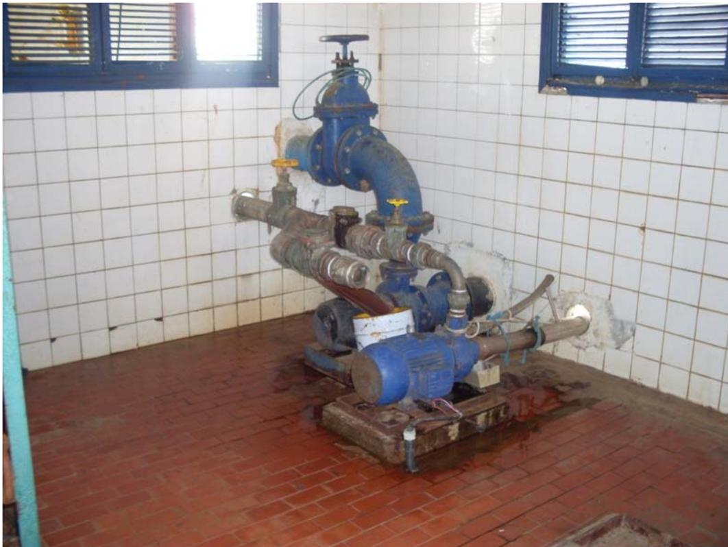
**Figura 4.139: Bombas de água tratada na ETA de Milhã.**
