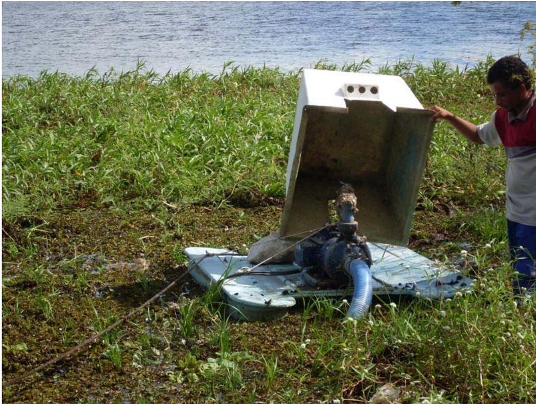
**Figura 4.10: Sistema de captação usado no açude Berilópolis para atender ao suprimento de Açude Novo, Alto Santo (Cabeça de Boi), Grossos, Furnas e Tabuleiro.**
