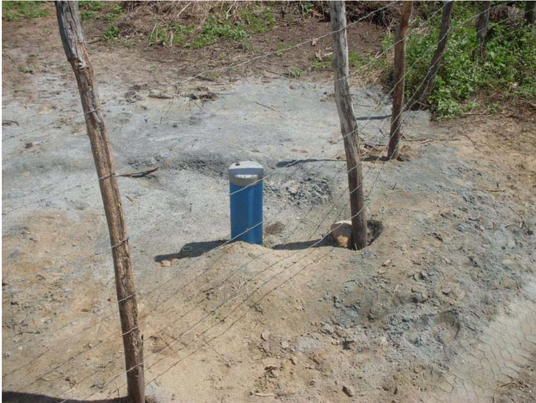
**Figura 4.79: Poço profundo construído em Esperança, vazão = 3.000 L/h.**
