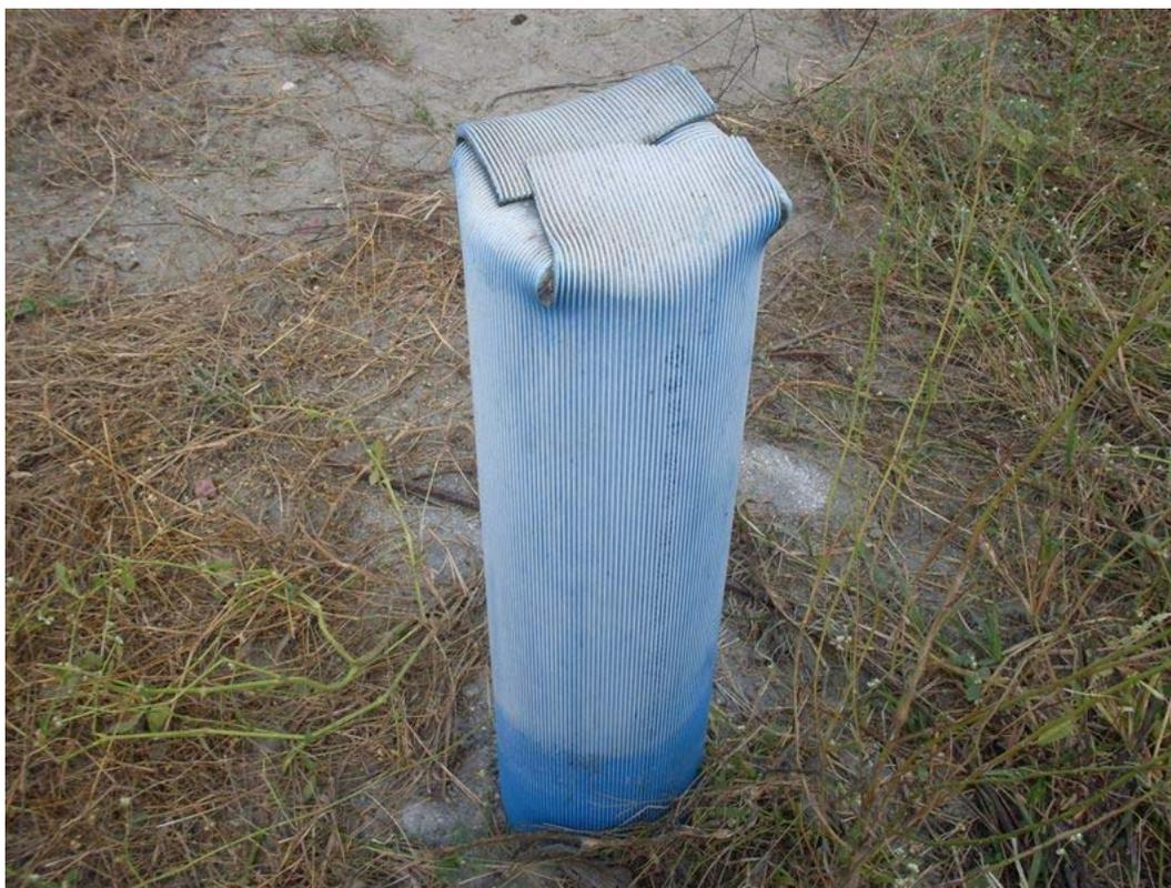
**Fig. 4.175: Segundo poço lacrado no KM 21 por insuficiência d'água.**
